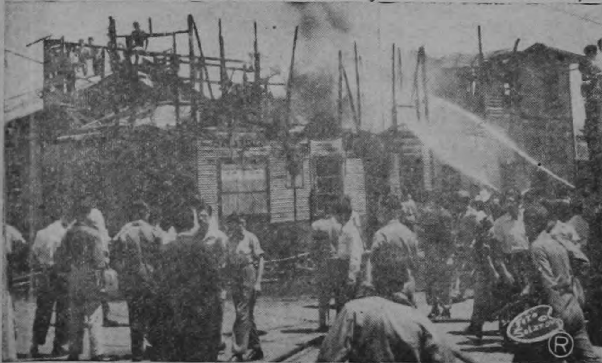
AQUÍ COMENZO: Fue en esto, donde estaba el establecimiento de licores "El Diamante", en los cuartos del alto, donde sólo escombros se aprecian, donde se inició el fuego.
